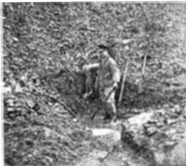
Abb. 3. Der von den Franzosen erbaute Sammelkanal ist durch abgespülte Haldenberge 2 m hoch überdeckt.
